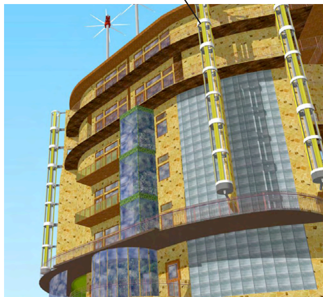
Roterande cylindervindkraftverk som fångar fasadvindar
